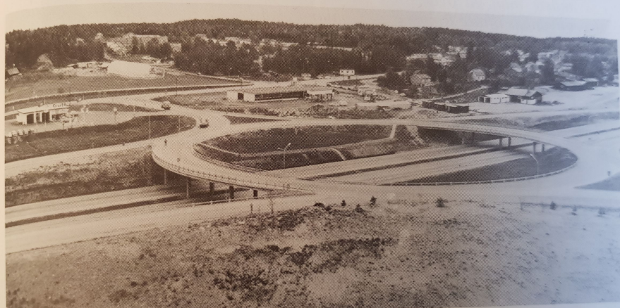
Glädjens trafikplats innan Sandavägen fick sin nuvarande sträckning. Glädjen hörde egentligen till Johannesdal som ligger till höger i bilden. Odensgården syns i backen till vänster i bilden och i mitten syns OK:s bensinstation som är under byggnation. Observera vänstertrafiken!
